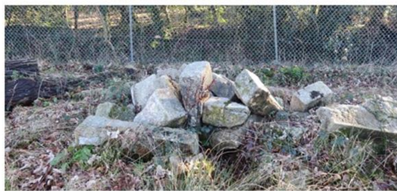
Récupération de moellons, Mise en tas - Troncs bois mort en arrière
