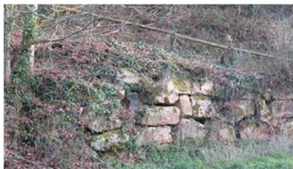
Soutènement Blocs appareillés
